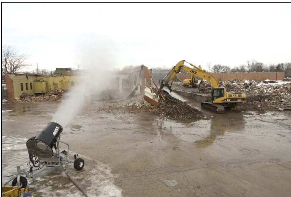
Obr. 2. Tryskkové rozstříkování při demolicích
