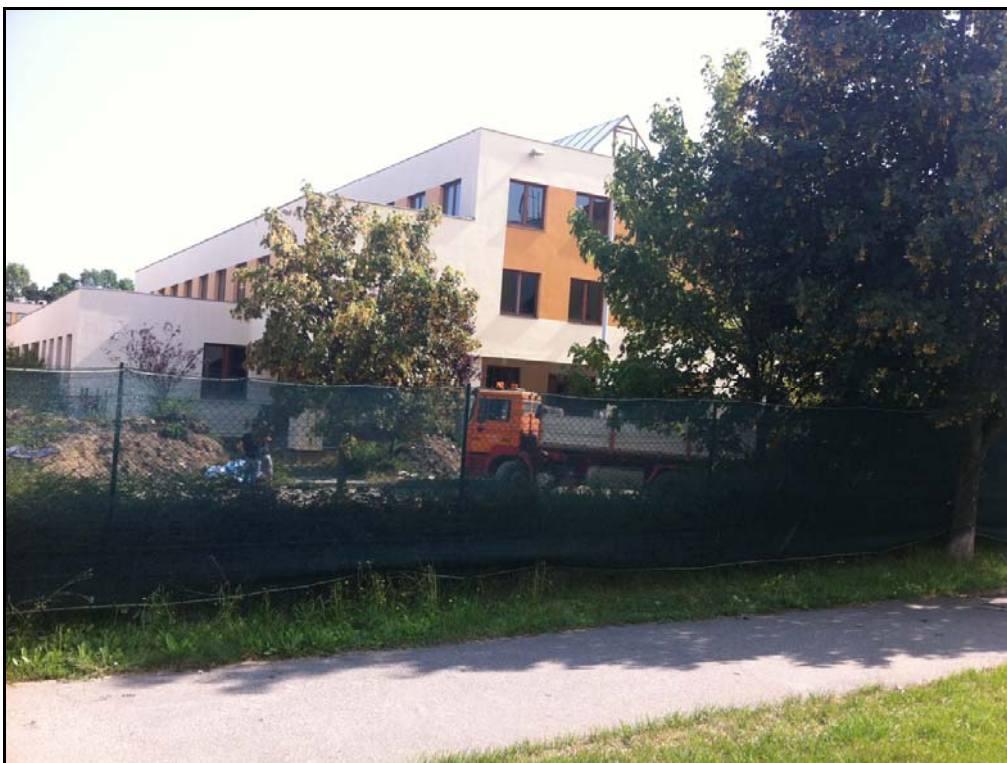
Obr. 4. Použití tkaniny pro redukci prašnosti po obvodu staveniště
