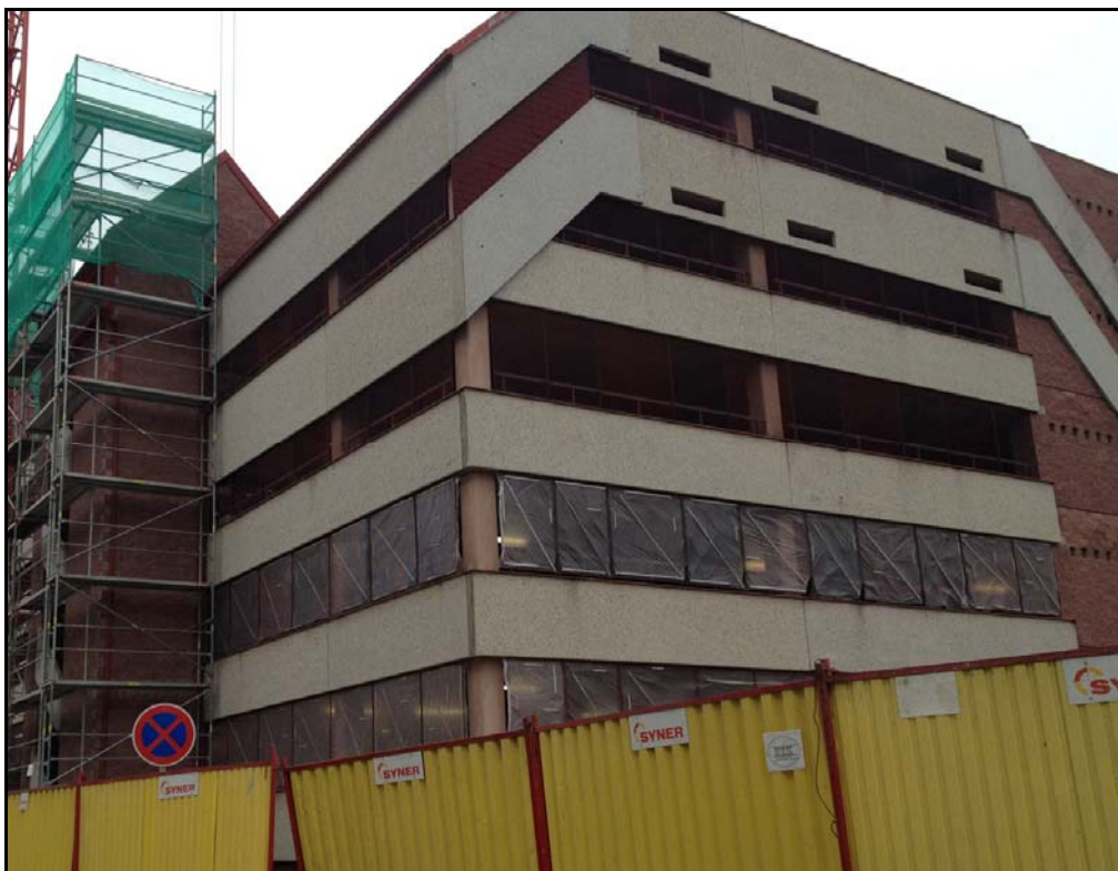
Obr. 3. Použití fólie pro omezení prašnosti v průběhu prací uvnitř objektu
